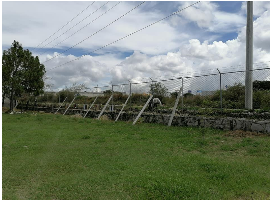
Reparación de 40 metros de barda perimetral, agosto de 2020
