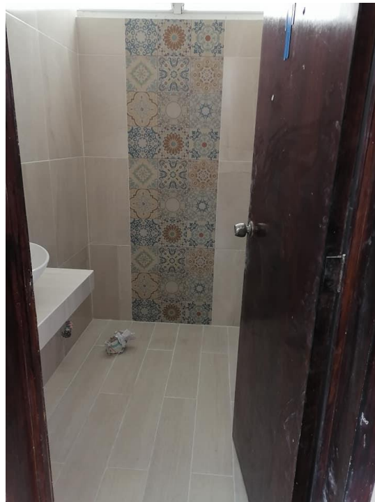
Remodelación de baños de oficinas administrativas y de alumnas, agosto de 2020
