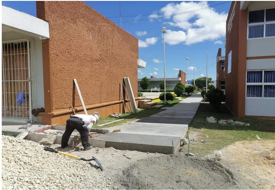
Ampliación de pasillo entre edificios administrativos y edificios A y B de Salones, julio de 2020
